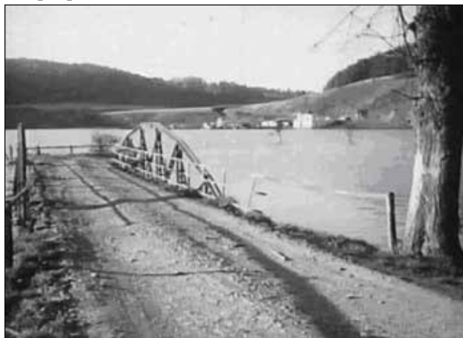
Ocelový most na původním místě v údolí řeky Moravice při výstavbě přehrady
