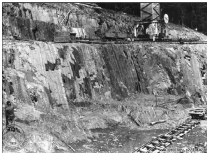
Přehledný snímek zachycující v celku část levého boku výlomu pro vodní dílo na řece Moravici, základová půda přehrady (kulm). Fotoarchiv České geologické služby [online databáze]. Praha, Česká geologická služba [cit. 2015-09-27]. Dostupné z URL http://www.geology.cz/foto/8608 , Foto Bohumil Červený, 1953
