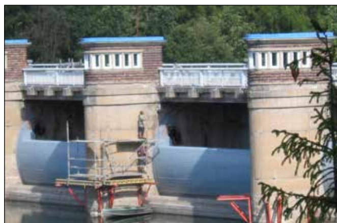
Začínající oprava koruny hráze Kružberské přehrady, Foto Jarmila Kaspříková, 2015.
