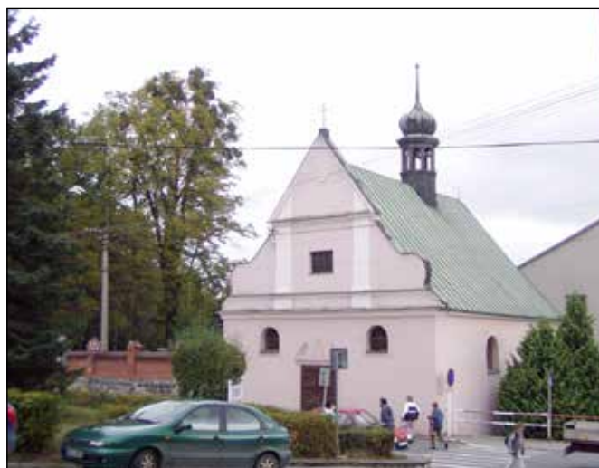
Hřbitovní kaple sv. Rodiny (foto před zahájením rekonstrukce)
