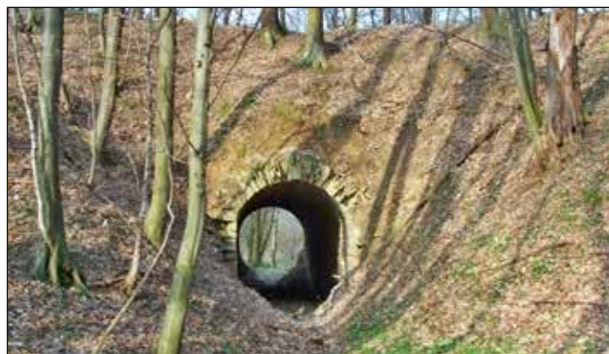
Propustek levobřežního přítoku Gručovky pod Děrným.
