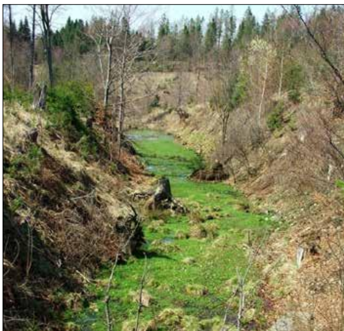
Vykopáný zářez na vrcholových úsecích trati poblíž Skřipova dnes slouží jako mokřadní biotop pro obojživelníky a vzácnější rostliny.
