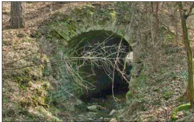
Propustek nad levobřežním přítokem Gručovky u nedokončeného železničního mostu pod Lukavcem.
