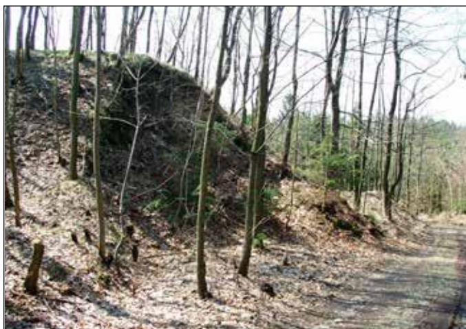
Násep nedokončeného železničního mostu nad lesní cestou u Skřipova.
