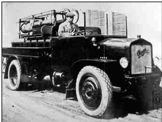
Hasicí vůz - výrobek továrny Oświęcim-Praga (vmax 5 km/h, spotřeba 15l / 100 km),www. ppoz.pl
