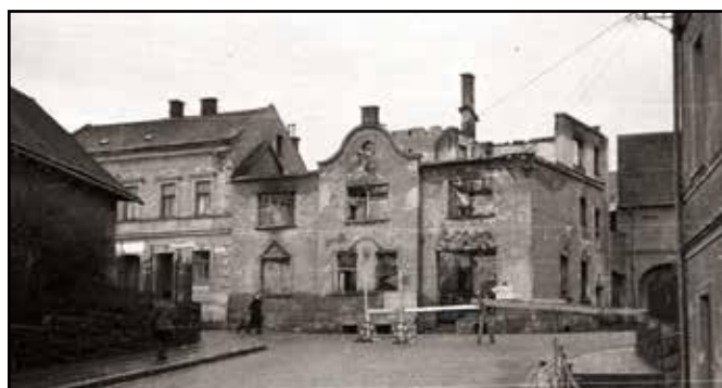
1946-1950. Odrý. Rozbořený dům dělostřeleckými granáty na křižovatce ulic 1. Máje a Nadační.
