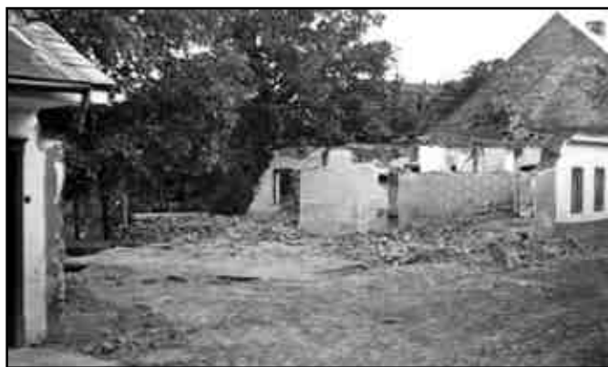
Odry 1946-1950. Demolice domu ve Staré ulici, zasaženého dělostřeleckým granátem.
