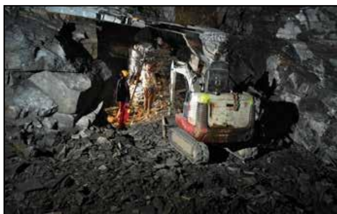
Práce na zpřístupnění Flascharova dolu
