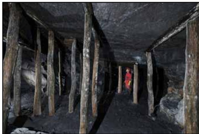
Dřevěné výztuže v dobývací komoře štol Nový Svět B
