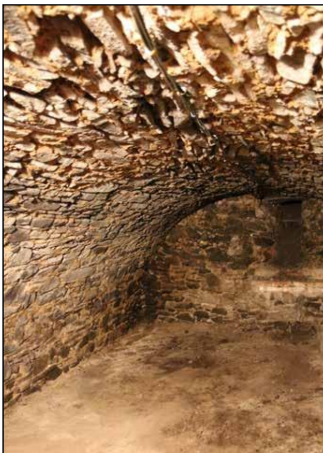
Sklepní prostor s valenou klenbou z lomového zdiva
