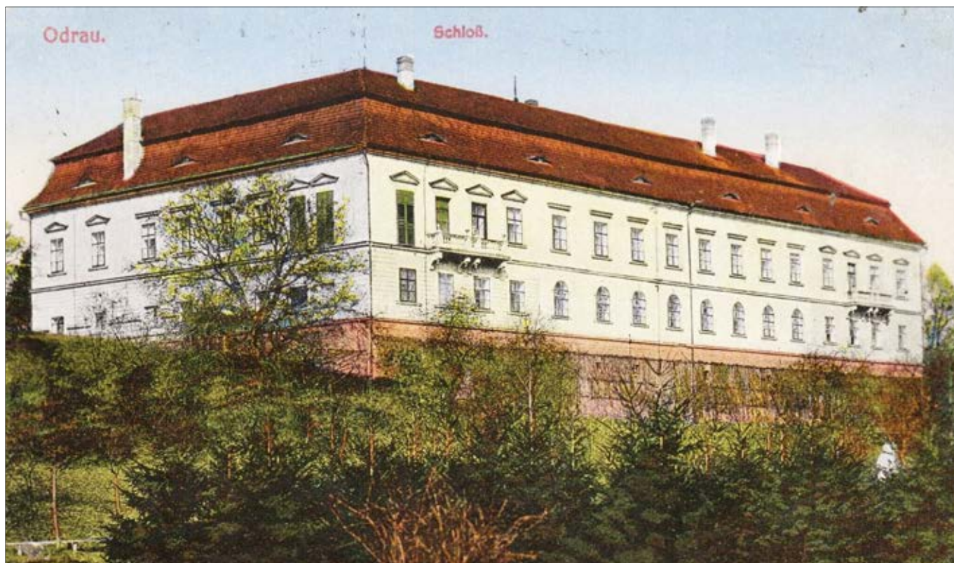
Odry, 1905. Pohled na budovu zámku ze zámeckého parku.
