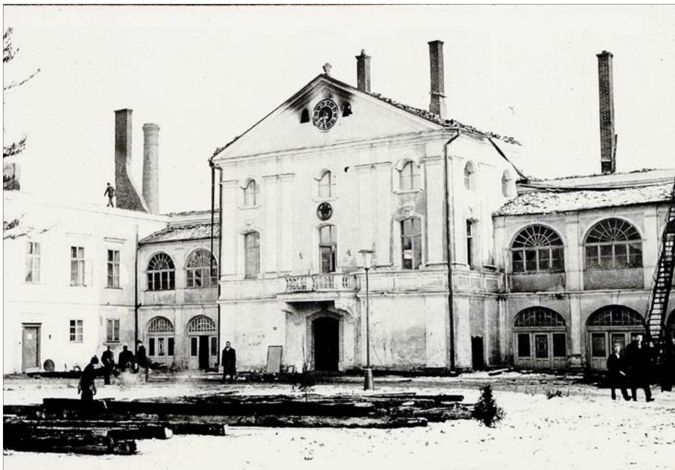
Odry, 1964. Zámek po požáru, pohled na průčelí zámku.
