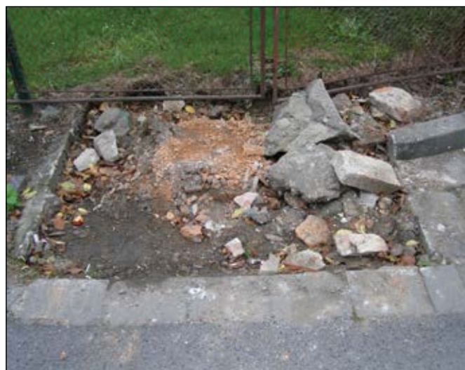
Základ kříže po jeho demontáži 30.11.2013
