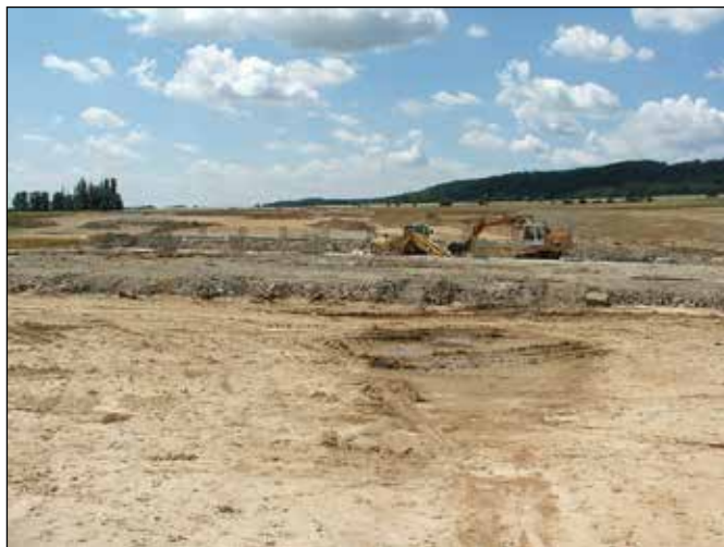
Stavba dálničního nadjezdu D47 u Emauz. Foto: Jiří Kucharz, 8/2007
