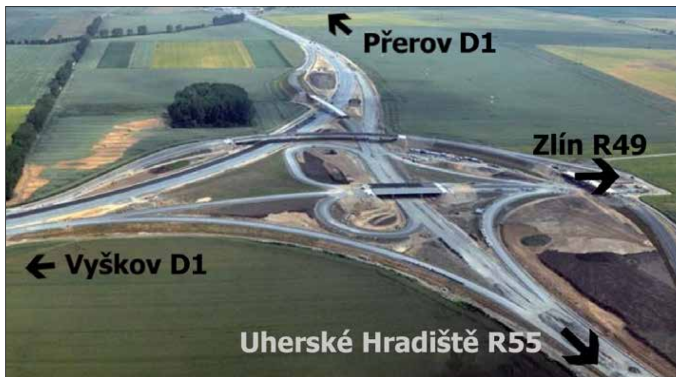
Křižovatka Hulín D1-R49-R55. Stavba 0135 byla v úseku Kroměříž-východ až Hulín uvedena do provozu 3. 12. 2010 a došlo tak díky navazující rychlostní silnici R55 k napojení Zlína na dálniční síť ČR.
