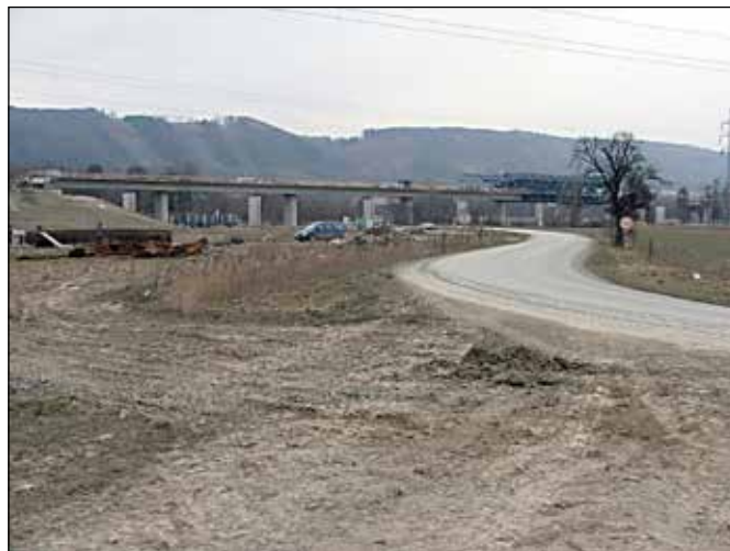
Stavba 800 m dlouhé estakády přes řeku Odru. Foto: Jiří Kucharz, 2/2008
