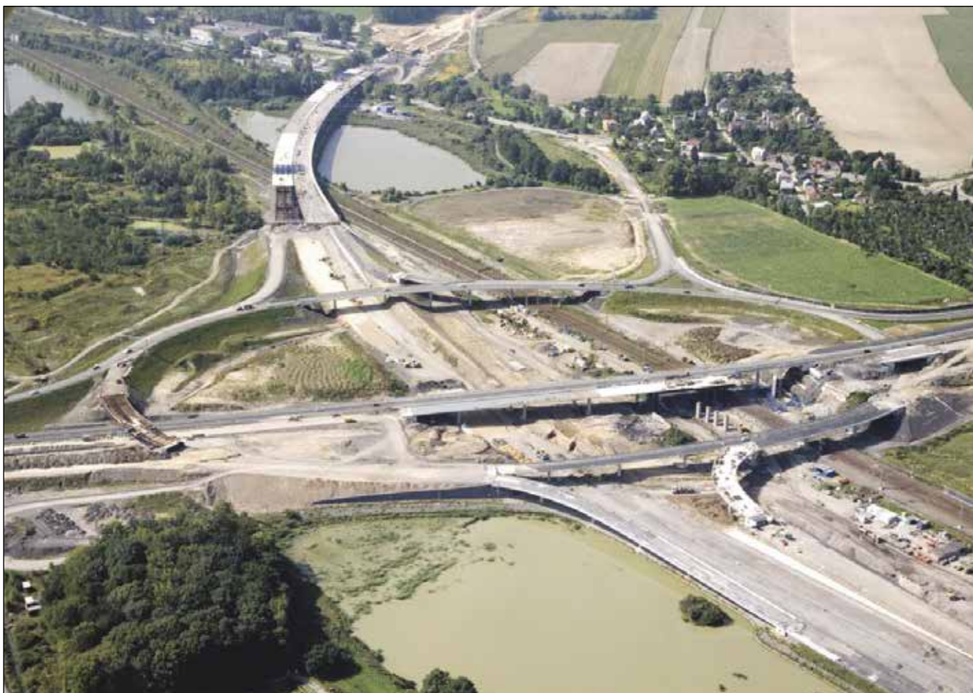
Největší staveniště posledních let – 80 km dlouhý projekt dálnice D47 (součást tahu D1 Praha–Brno–Ostrava). První úsek – křižovatka Rudná, byl slavnostně otevřen v roce 2007. Zdroj: publikace „70 let dálnic ve fotografii“ – www.rsd.cz
