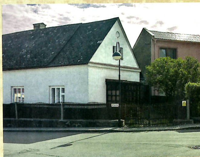
Dům č. p. 111 Foto: Jindra Kunc
