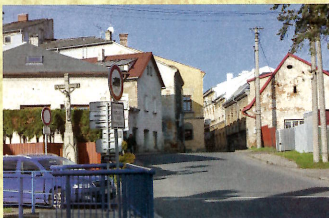
Dům č. p. 130. Foto: Jindra Kunc
