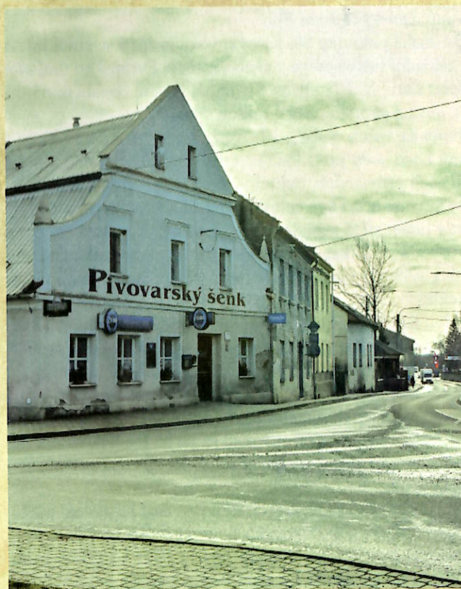
Dům č. p. 146. Foto: Jindra Kunc
