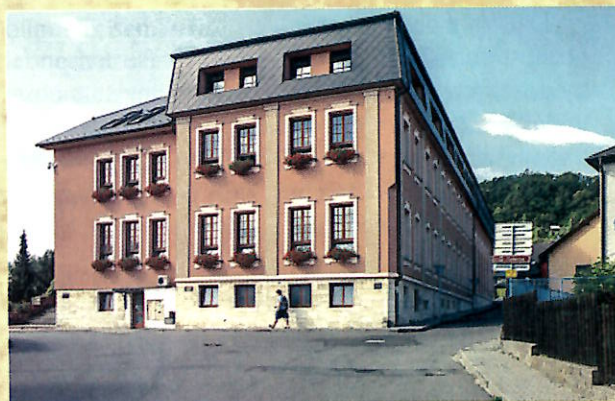
Dům č. p. 188 Foto: Jindra Kunc
