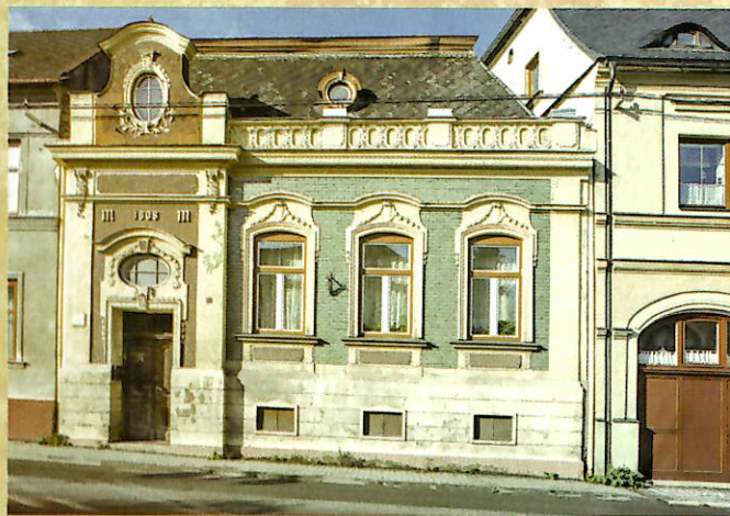
Dům č. p. 239. Foto: Jindra Kunc
