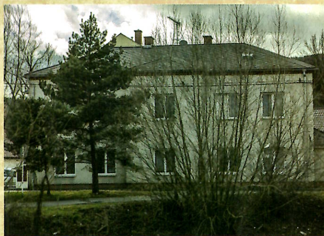
Dům č. p. 288. Foto: Jindra Kunc
