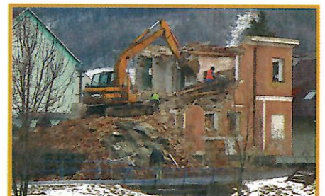
Demolice domu v roce 2017
