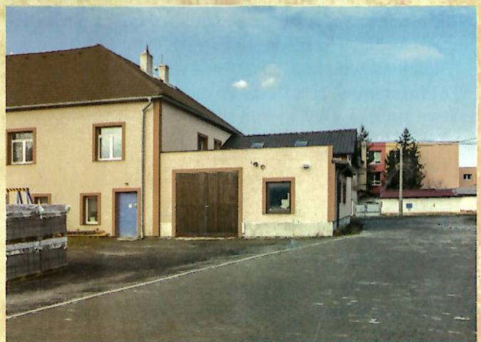
Dům č. p. 328 Foto: Jindra Kunc
