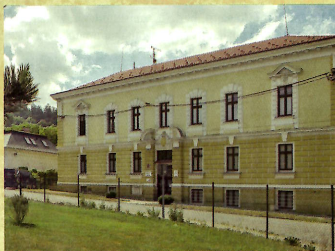
Dům č. p. 435. Foto: Jindra Kunc
