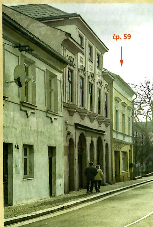
Dům č. p. 59 Foto: Jindra Kunc
