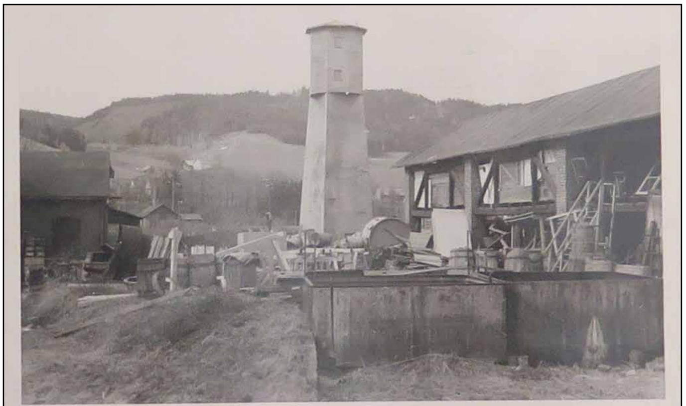
Záběry na stavební objekty uvnitř továrny z roku 1947. Zemský archiv v Opavě, fond Optimit, gumové a textilní závody, a. s., Odry
