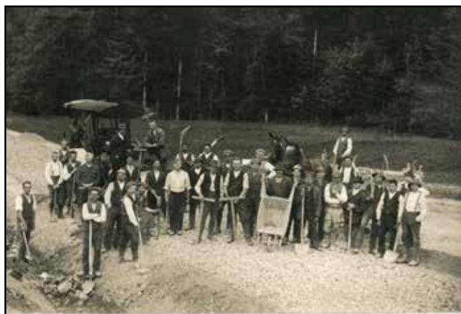
Stavba silnice z Jakubčovic do Dobešova.
